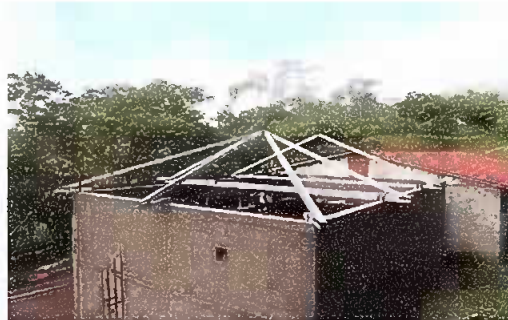
Foto 4, Cocina: Sustitución de lámina por lámina troquelada aluzinc calibre 26
