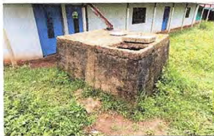
Foto 7, Depósito de Agua: Sustrución de tanque de concreto por depósito de agua
