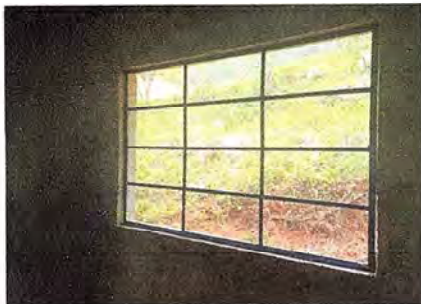
Foto 5, Módulo 1: Sustitución de ventanas de metal
