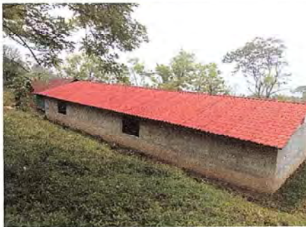
Foto 3, Módulo 1: Pintura interior y exterior
