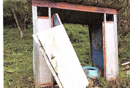
Foto 6, Baños: Reparación de pared (incluye cemento, soleras y columnas)
