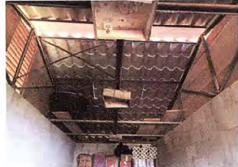
Foto 4, Módulo 1: Repello en muro
