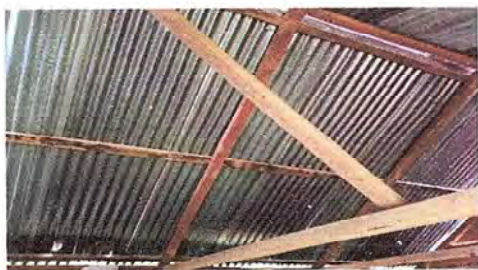
Foto 9, Cocina: Sustrución de lámina por lámina troquelada aluzinc calibre 26
