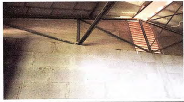
Foto 2, Módulo 1: Reparación de pared
