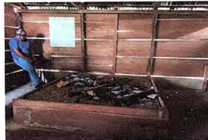
Foto 10, Cocina: Sustrución de estufa rural (completa) incluye chimenea y plancha de metal
