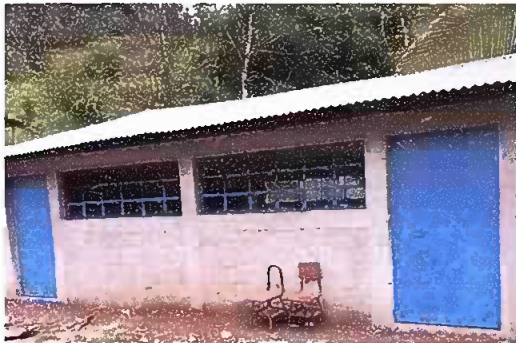
Foto 3: Modulo I: Sustitución de ventanas de madera por metal más vidrio
