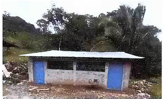
Foto 2: Modulo I: Sustitución de puerta
