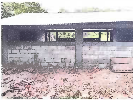
Foto 1: Modulo I: Reparación de muro de Block
