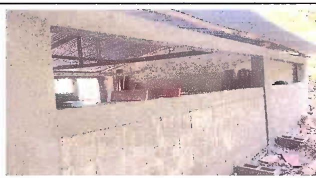
Foto 2: Durante la construcción la escuela pared de atras, talladas y repellos de las columnas, y coronas
