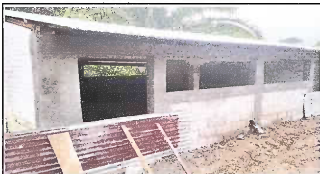
Foto 3: Levantamiento de pared, tallada y repellos de columnas y corona en frente
