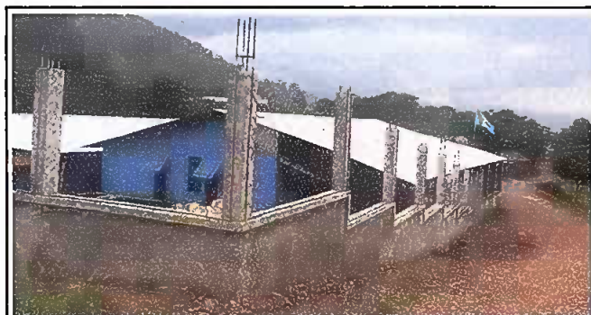
Módulo 2: El trabajo realizado y concluido del muro perimentral con soleras, columnas y malla.
