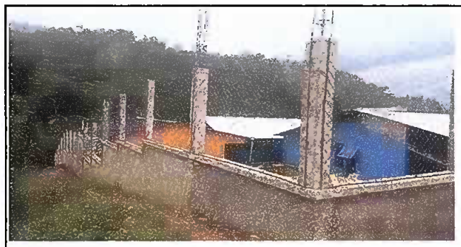
Módulo 2: El muro perimentral terminado.
