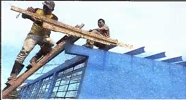
Módulo1: Sustitución de lámina por lamina troquelada del aula de la escuela
