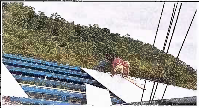
Módulo 1: se observa la colocacion de las ultimas de pliego de laminas troquelada.
