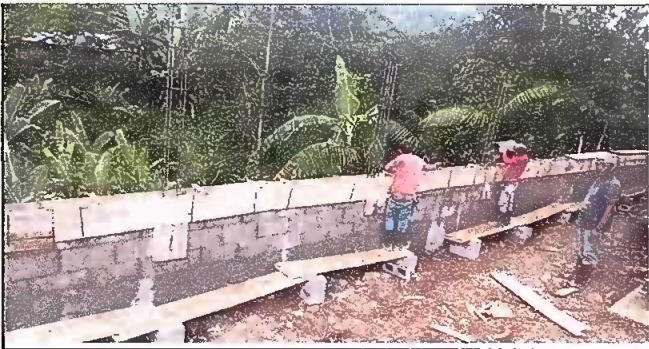
Módulo 2: Colocando las tablas y la fundicion de la solera del murro.
