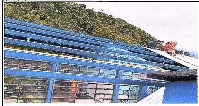
Módulo 1: Colocación de la lamina troquelada en las dos aulas
