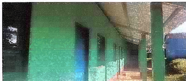
Foto No. 2: Sustitución de estructura de soporte de madera, por metal
