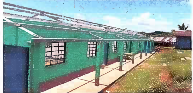
Foto No. 2: Sustitución de estructura de soporte de madera, por metal
