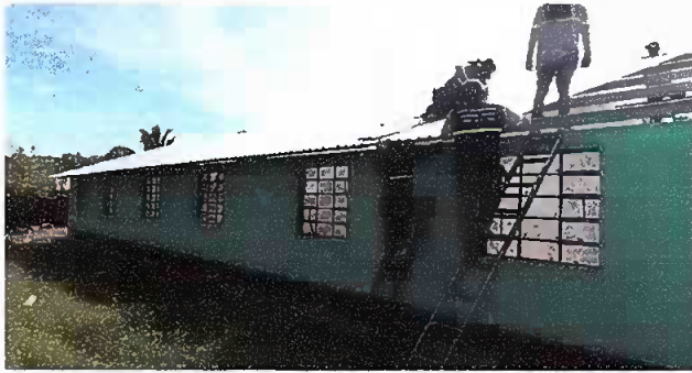
Foto No. 1: Sustitución de lamina por lamina troquelada calibre 26, de capote de lamina unilateral troquelada
