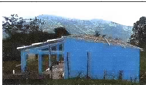
Foto No.2: MODULO I. Sustitucion de soporte de madera por estructura metálica.
