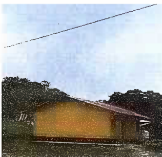
Foto No.5: MODULO II. Sustitución de techo de cocina escolar por estructura metálica y lamina troquelada calibre 26.
