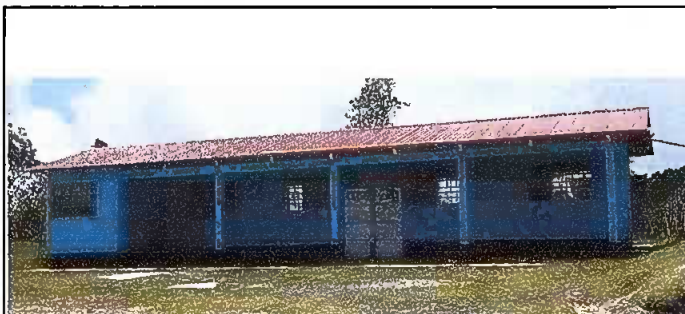
Foto No. 1: MODULO I. Sustitución de laminas en mal estado por lámina troquelada alucinc roja calibre 26.
