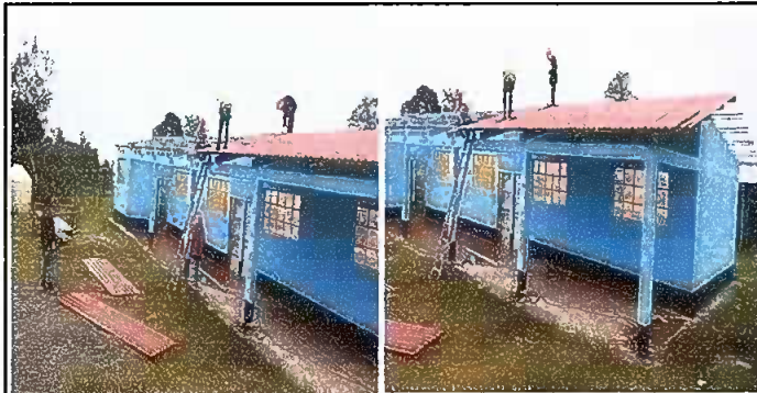
Foto No. 1: MODULO I. Sustrucción de laminas en mal estado por lámina troquelada alucinc roja calibre 26.
