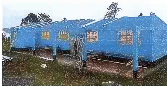
Foto No.2: MODULO I. Sustrucción de soporte de madera por estructura metálica.
