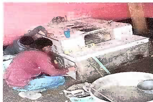
Foto No.6: MODULO II. Instalación de azulejo y sustitución de plancha y chimenea en estufa rural.
