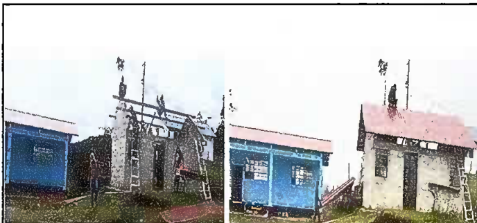
Foto No.5: MODULO II. Sustrucción de techo de cocina escolar por estructura metálica y lámina troquelada calibre 26.
