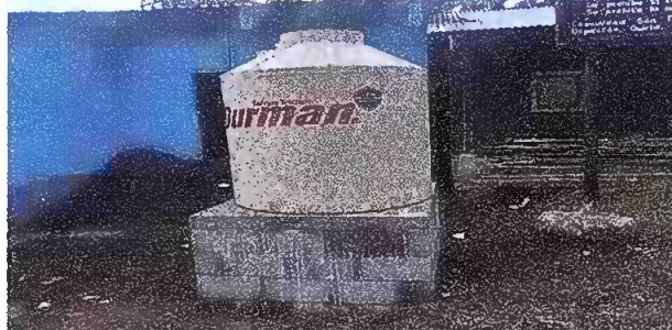
Foto 4: Construcción y ubicación de tinaco
