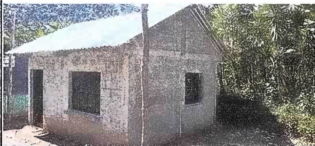
Foto 3: Cocina escolar y puerta
