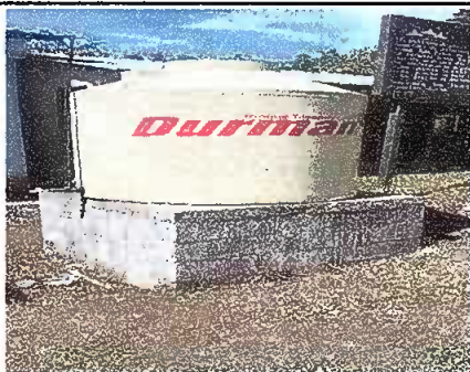
Foto 5: Instalación de tinaco.
