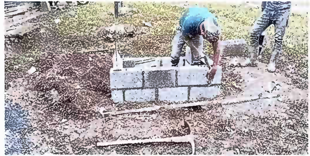
Foto 4: Durante la construcción e instalación de tinaco.
