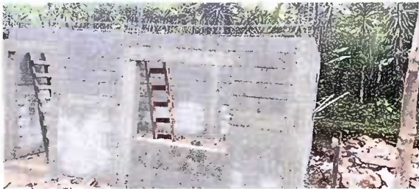
Foto 3: Levantamiento de pared de cocina
