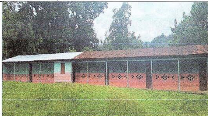
MODULO 1. FOTO 1 Y 2 Sustitucion de lamina, por lamina troqueladaa luzinc calibre 26 Sustitucion de capote de lamina para lamina troquelada
