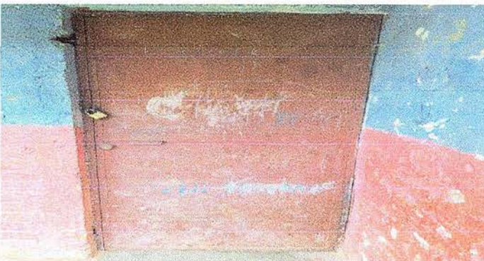
MODULO 1. FOTO 3 Mantenimiento a estructura (lijado, cambio de tubo, sepillada, sugeciones, aplicación de pintura) (seva utilizar planta electra) Sustitucion de chapa
