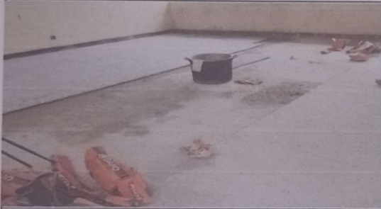
Foto 1: Modulo 1: Sustitución de piso de torta de concreto por piso de granito
