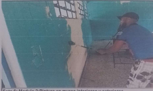
Foto 6: Modulo 2: Pintura en muros interiores y exteriores.
