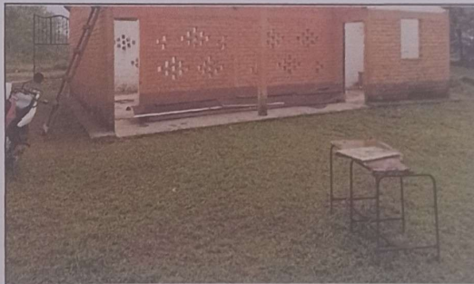
Foto 4: Modulo 2: Sustitución de puertas y ventanas de madera por metal
