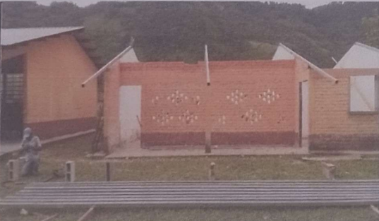
Foto 3: Modulo 2: Sustitución de estructura de soporte de madera por metal.
