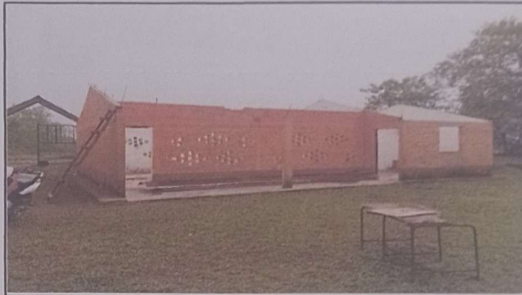
Foto 2: Modulo 2: Sustitución de lamina, por lamina troquelada aluzinc calibre 26, capote y tornillos
