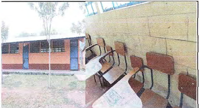
Foto 6: Módulo 2. Pintura en muros interiores y exteriores
