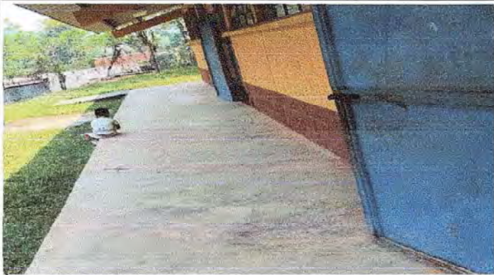
Foto 1: Módulo 1. Sustrucción de piso de torta concreto por piso de granito
