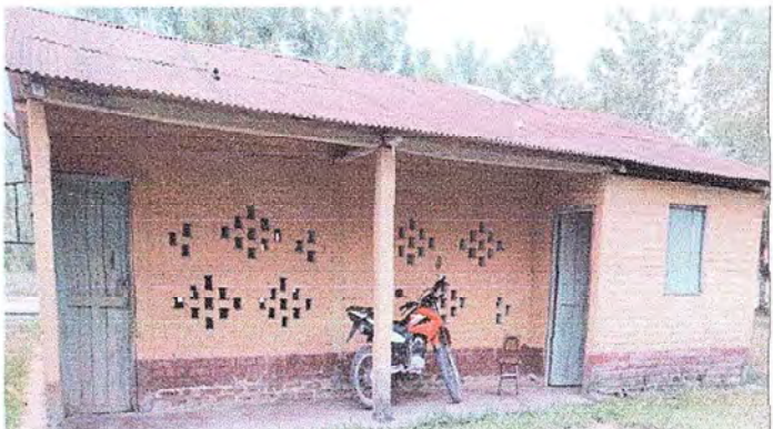
Foto 4: Módulo 2. Sustrucción de puertas y ventanas de madera por metal
