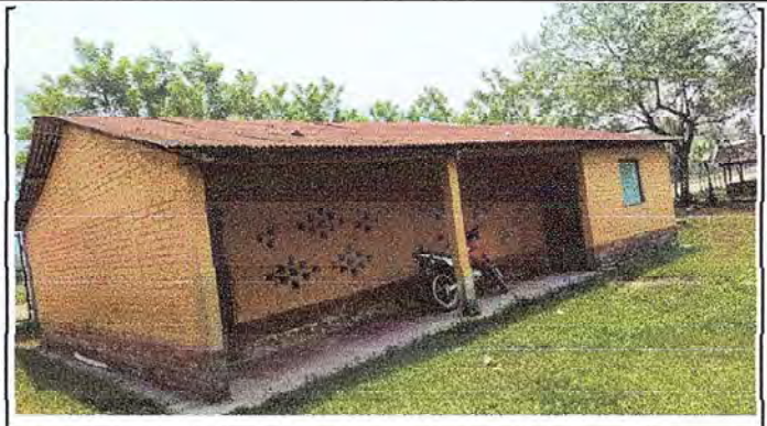
Foto 2: Módulo 2. Sustrucción de lámina, por lamina troquelada aluzinc calibre 26, capote y tornillos
