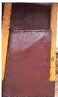
Foto 5: Mantenimiento de puertas
