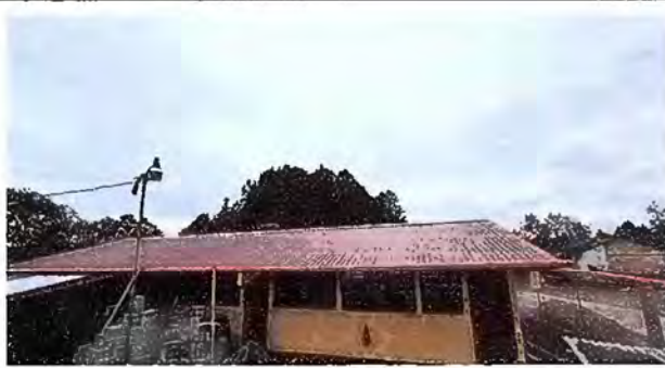
Foto 1: Modulo 1: sustitución de lamina por lamina troquelada y de canal en mal estado por tubo pvc.
