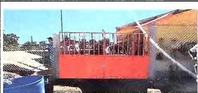
Foto 4: Fundición de columnas y Sustitución de portón en mal estado.
