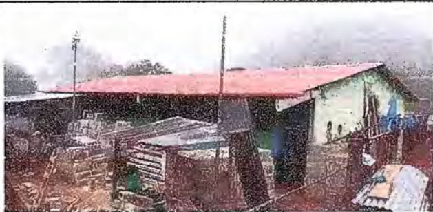
Foto 1: Modulo 1: sustitución de lamina por lamina troquelada y de canal en mal estado por tubo pvc.
