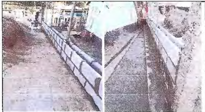
Foto 2: Modulo 1: Construcción de muro frontal.
