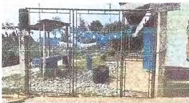
Foto 4: Sustitución de portón en mal estado.
