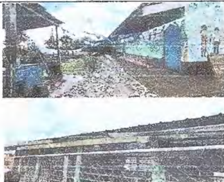
Foto 1: Modulo 1: Mantenimiento a puertas de metal, sustitucion de canal en mal estado por canal pvc y pintura interior y exterior del modulo.
