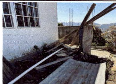
Foto 10: MURO PERIMETRAL ANEXO A LA COCINA TOTALMENTE COLAPSADO, REPRESENTANDO UN PELIGRO A USUARIOS.
