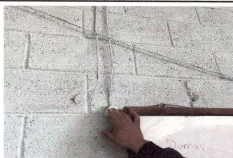
Foto 6: INSTALACIONES ELECTRICAS DE LAS AULAS, EXPUESTAS.
