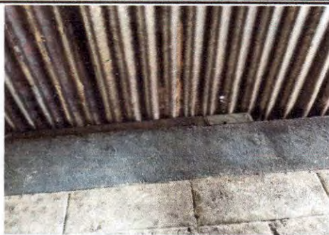
Foto 7: LAMINA DEL TECHO DE LA COCINA, MUY DETERIORADA Y CON FILTRACIONES.
