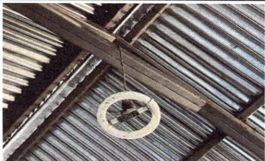
Foto 5: LAMPARAS DE AULAS EN MAL ESTADO, SIN ILUMINACION.
