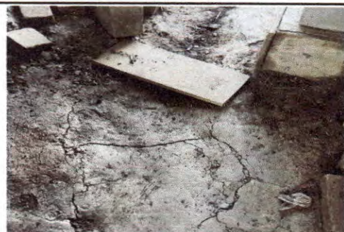
Foto 9: ACTUALMENTE LA COCINA NO CUENTA CON PISO FIRME, SIENDO ESTE DE TIERRA.
