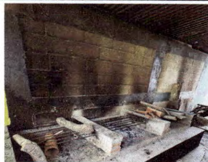
Foto 8: REPARACION Y AMPLIACION DE ESTUFA DE LEÑA.
