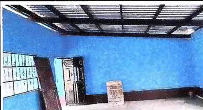
Foto 3: MODULO 1: MANTENIMIENTO A ESTRUCTURA DE SOPORTE
