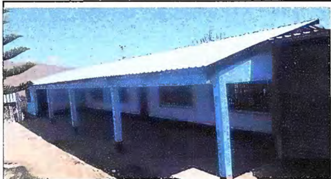
Foto1: MODULO 1: SUSTITUCION DE LÁMINA
