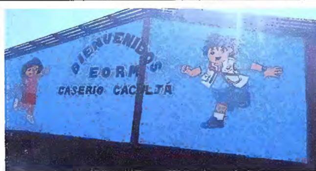
Foto 8: MODULO 1: PINTURA EXTERIOR E INTERIOR
