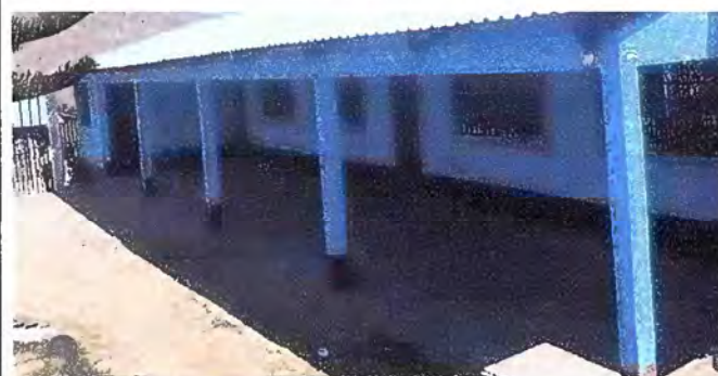
Foto 4: MODULO 1: PINTURA EXTERIOR E INTERIOR
