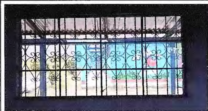
Foto 5: MODULO 1: SUSTITUCIÓN DE VIDRIOS
