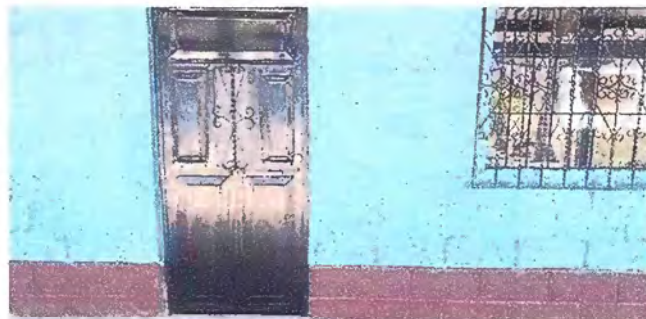
Foto 2: MODULO 1: SUSTITUCION DE PUERTAS
