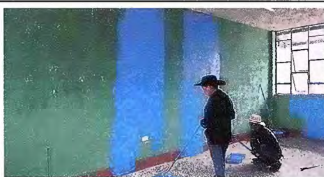
Foto 4: MODULO 1: PINTURA EXTERIOR E INTERIOR
