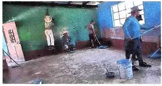
Foto 8: MODULO 1: PINTURA EXTERIOR E INTERIOR
