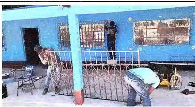
Foto 6: MODULO 2. SUSTITUCION DE BALCONES
