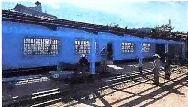
Foto 1: MODULO 1: SUSTITUCION DE LÁMINA
