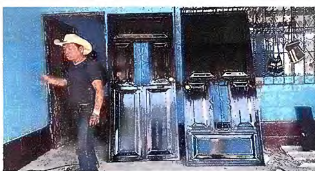
Foto 2: MODULO 1: SUSTITUCION DE PUERTAS
