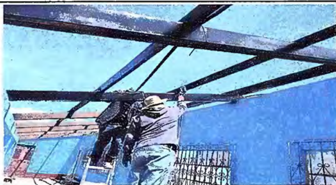
Foto 3: MODULO 1: MANTENIMIENTO A ESTRUCTURA DE SOPORTE
