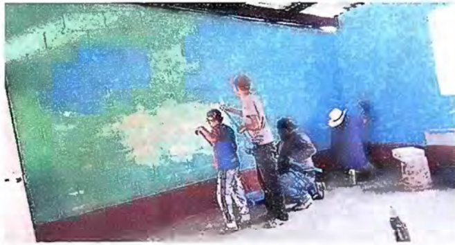
Foto7: MODULO 2: PINTURA EXTERIOR E INTERIOR
