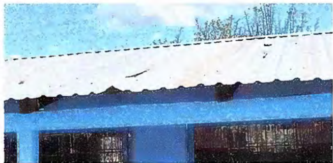
Foto 1: MODULO 1: SUSTITUCION DE LÁMINA
