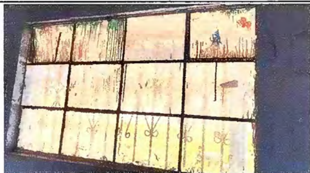
Foto 5: MODULO 1: SUSTITUCIÓN DE VIDRIOS
