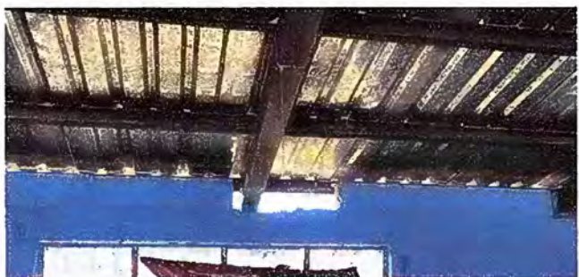
Foto 3: MODULO 1: MANTENIMIENTO A ESTRUCTURA DE SOPORTE
