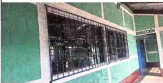
Foto 4: MODULO 1: SUSTITUCION DE BALCONES
