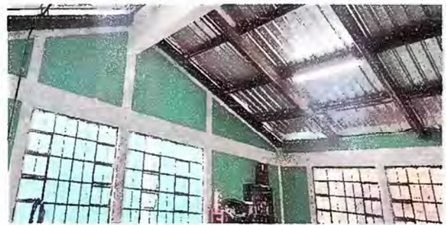
Foto 5: MODULO 1: SUSTITUCION DE VIDRIOS
