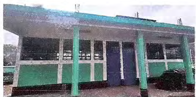
Foto 7: MODULO 2: MANTENIMIENTO DE PUERTAS
