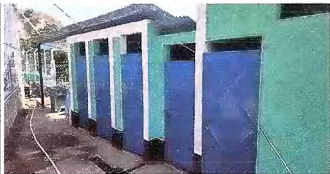
Foto 7: MODULO 3: MANTENIMIENTO DE PUERTAS
