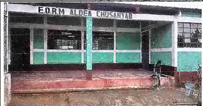
Foto 9: PINTURA GENERAL EN MUROS EXTERIORES E INTERIORES
