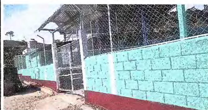
Foto 8, MURO PERIMETRAL, REPARACIÓN DE MALLA
