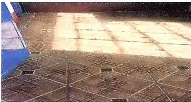
Foto 6: MODULO 1: SUSTITUCION DE PISO
