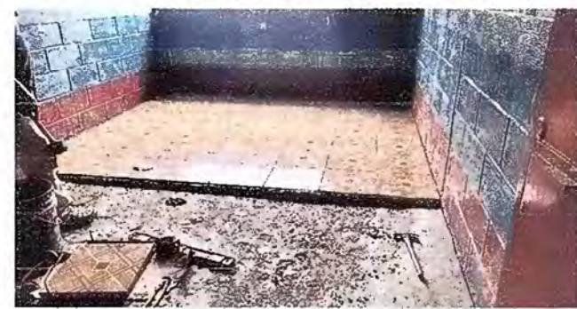
Foto 6: MODULO 1: SUSTITUCION DE PISO
