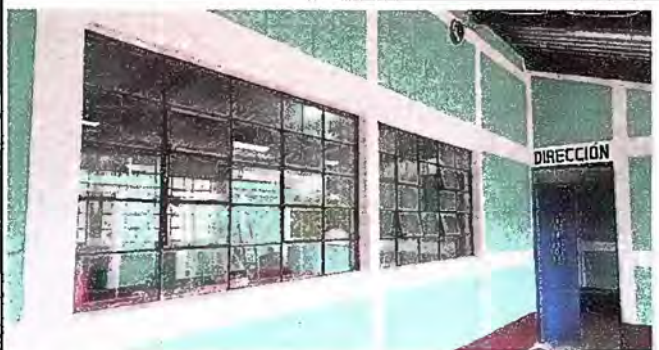
Foto 5: MODULO 1: SUSTITUCION DE VIDRIOS
