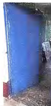
Foto 7: MODULO 2: MANTENIMIENTO DE PUERTAS
