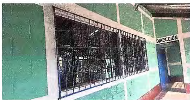
Foto 4: MODULO 1: SUSTITUCION DE BALCONES
