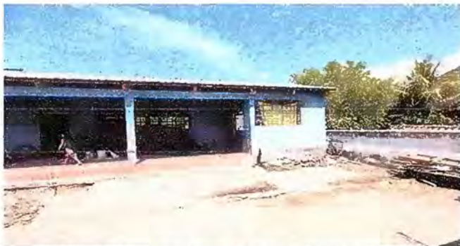
Foto 10: PINTURA GENERAL EN MUROS EXTERIORES E INTERIORES
