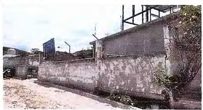
Foto 8, MURO PERIMETRAL, REPARACIÓN DE MALLA
