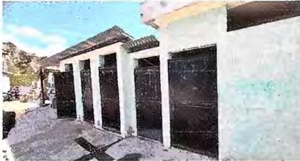
Foto 7: MODULO 3: MANTENIMIENTO DE PUERTAS
