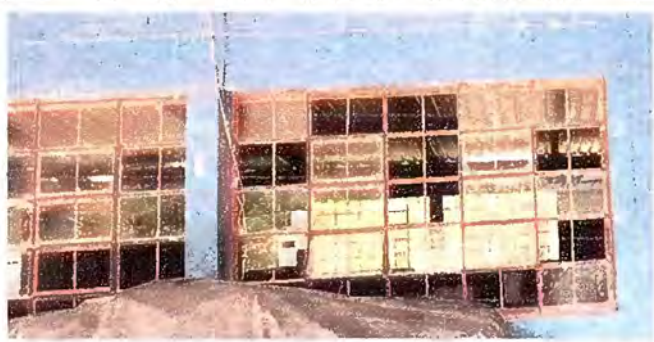
Foto 4: MODULO 1: SUSTITUCION DE BALCONES
