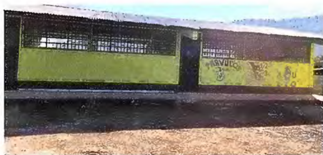
Foto 9: MODULO 3: PINTURA DE MUROS EXTERIORES E INTERIORES
