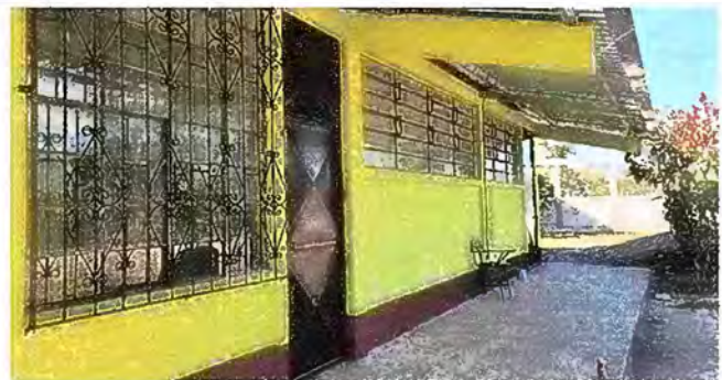
Foto 5: MODULO 1: PINTURA EN MUROS EXTERIORES E INTERIORES
