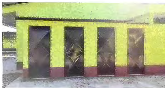
Foto 4: MODULO 3: MANTENIMIENTO A PUERTAS DE SANITARIOS
