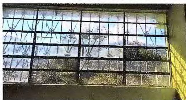
Foto 4: MODULO 1: SUSTITUCION DE VIDRIOS EN VENTANAS
