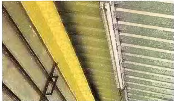
Foto7: MODULO 2: SUSTITUCION DE LAMPARAS
