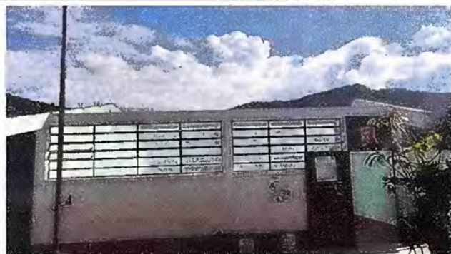
Foto1: MODULO 1: CAMBIO DE LAMINA
