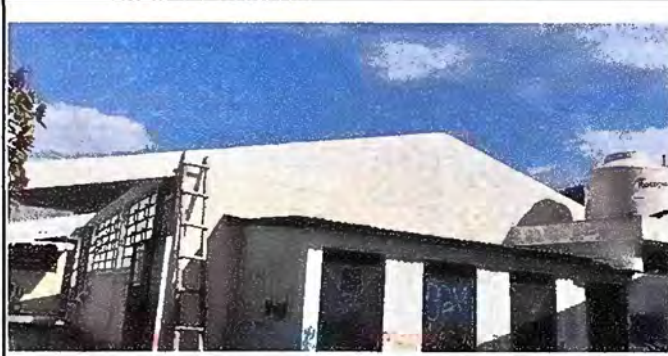
Foto 2: MODULO 1: CAMBIO DE ESTRUCTURA SOPORTANTE DE TECHO
