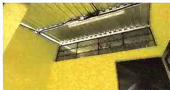
Foto 3: MODULO 1: SUSTITUCIÓN DE LAMPARAS E INSTALACION ELECTRICA
