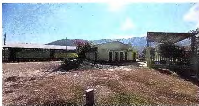
Foto 9: MODULO 3: PINTURA DE MUROS EXTERIORES E INTERIORES
