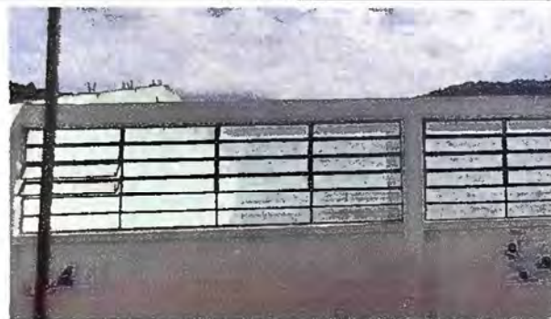
Foto 4: MODULO 1: SUSTITUCIÓN DE VIDRIOS EN VENTANAS
