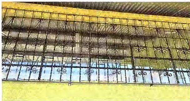
Foto 8: MODULO 2: SUSTITUCION DE BALCONES DE METAL
