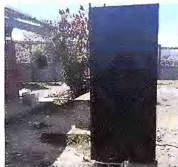
Foto 4: MODULO 3: MANTENIMIENTO A PUERTAS DE SANITARIOS
