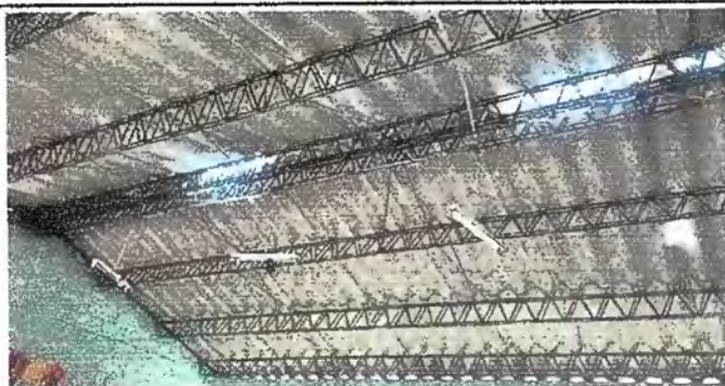
Foto1: MODULO 1: CAMBIO DE LAMINA
