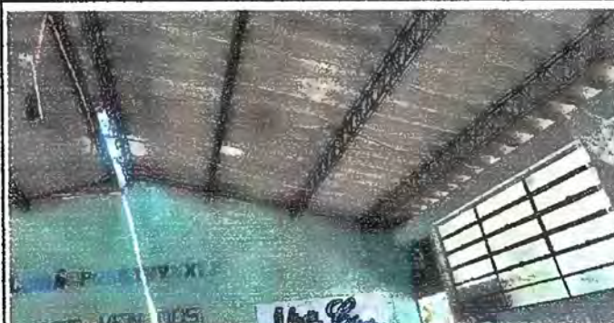
Foto 2: MODULO 1: CAMBIO DE ESTRUCTURA SOPORTANTE DE TECHO
