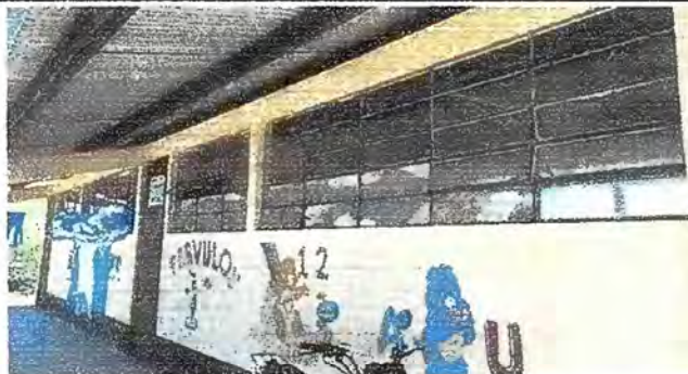
Foto 7: MODULO 2: SUSTITUCION DE BALCONES DE METAL
