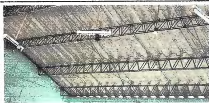
Foto 3: MODULO 1: SUSTITUCIÓN DE LAMPARAS E INSTALACION ELECTRICA
