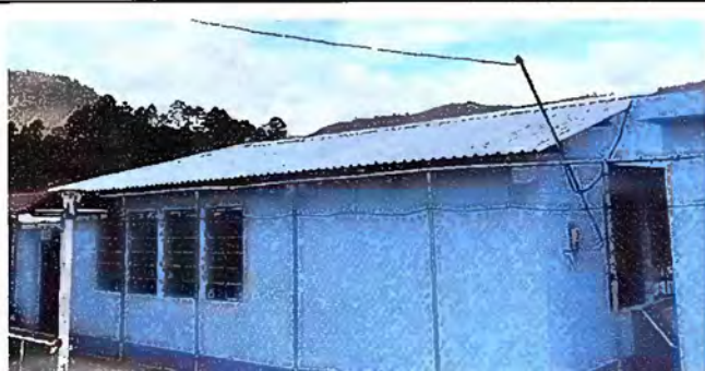
Foto1: MODULO 1: SUSTITUCION DE LÁMINA
