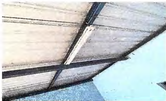
Foto 7: MODULO 2: SUSTITUCION DE LÁMPARAS
