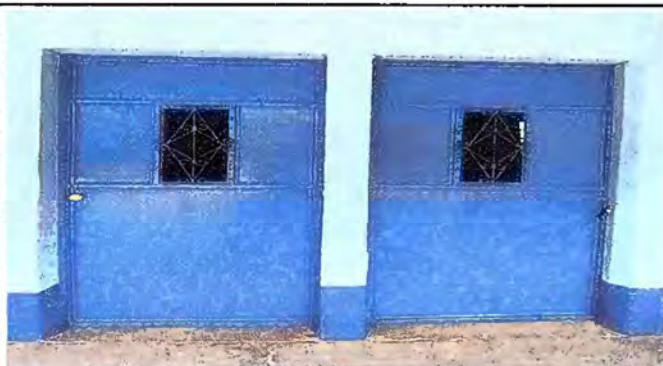
Foto 9: MODULO 2: MANTENIMIENTO A PUERTAS
