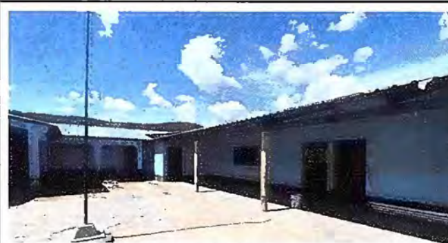
Foto 6: MODULO 2: PINTURA EN MUROS EXTERIORES E INTERIORES
