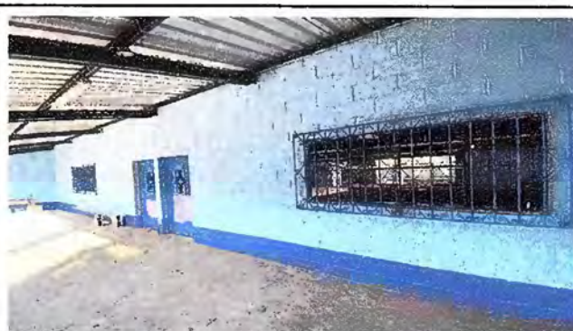
Foto 10: MODULO 2: MANTENIMIENTO DE BALCONES
