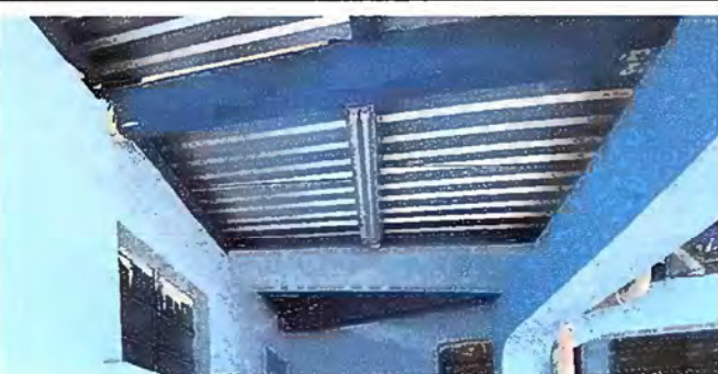
Foto 3: MODULO 1: REPARACION DE CABLEADO ELECTRICO
