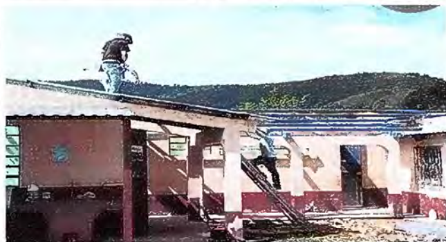
Foto1: MODULO 1: SUSTITUCION DE LÁMINA
