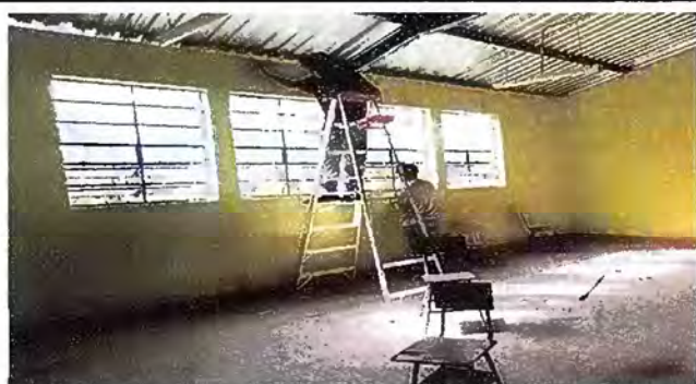
Foto 3: MODULO 1: REPARACION DE CABLEADO ELECTRICO
