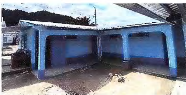
Foto 5: MODULO 1: PINTURA EN MUROS EXTERIORES E INTERIORES
