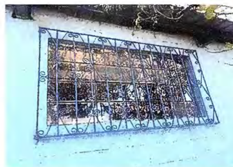
Foto 10: MODULO 2: MANTENIMIENTO DE BALCONES
