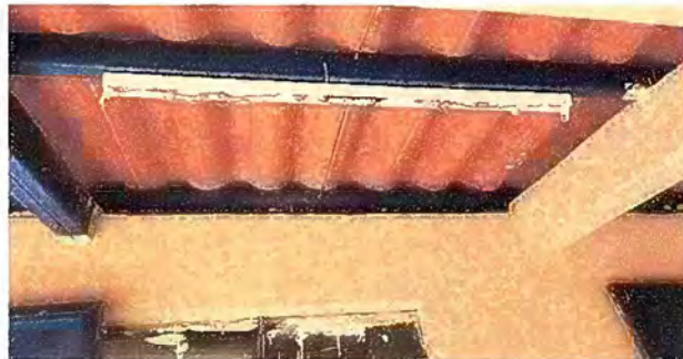
Foto 2: MODULO 1: SUSTITUCION DE LÁMPARAS
