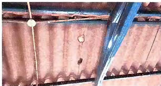
Foto 3: MODULO 1: REPARACION DE CABLEADO ELECTRICO
