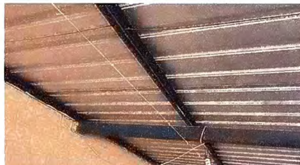
Foto 8: MODULO 2: REPARACION DE CABLEADO ELECTRICO
