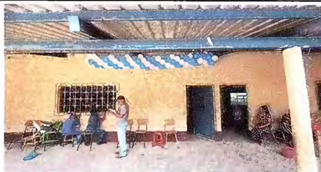
Foto 6: MODULO 2: PINTURA EN MUROS EXTERIORES E INTERIORES
