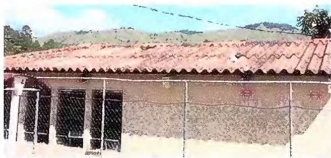
Foto1: MODULO 1: SUSTITUCION DE LÁMINA
