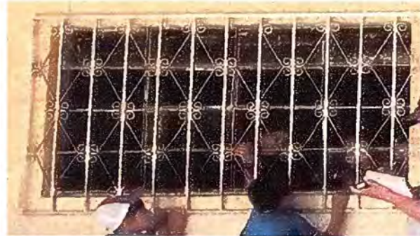
Foto 10: MODULO 2: MANTENIMIENTO DE BALCONES
