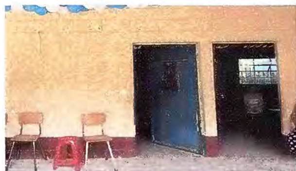
Foto 9: MODULO 2: MANTENIMIENTO A PUERTAS
