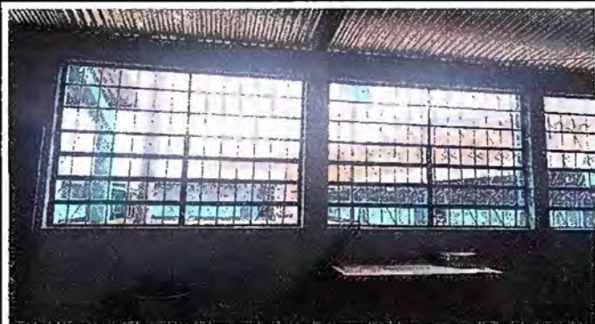
Foto 7: Módulo 3: Sustitución de vidrios
