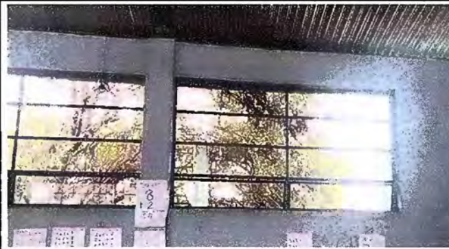
Foto 8: Módulo 3: Construcción de balcones de metal
