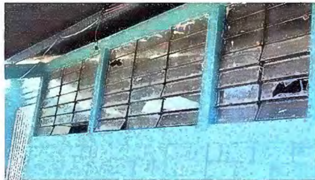
Foto 5: Módulo 2: Sustitución de vidrios
