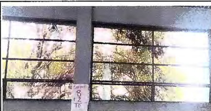
Foto 9: Módulo 4: sustitución de vidrios
