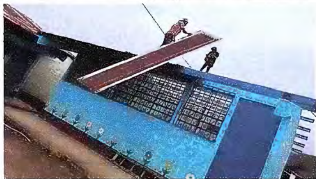
Foto1: Módulo 1: Sustitución de Lámina
