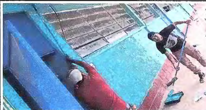
Foto 4: Pintura en paredes exteriores e interiores
