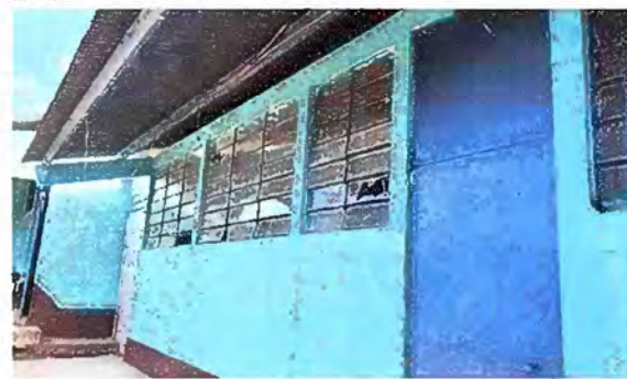
Foto 6: Módulo 2: Construcción de balcones de metal
