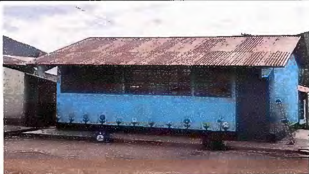
Foto1: Modulo 1: Sustitución de Lámina
