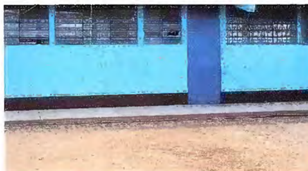
Foto 4: Pintura en paredes exteriores e interiores
