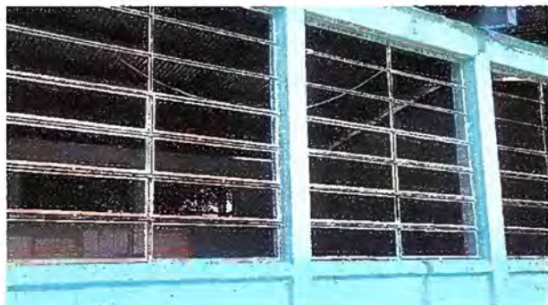
Foto 7: Módulo 3: Sustitución de vidrios
