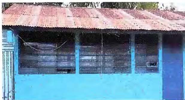
Foto 3: Módulo 2: sustitución de Lámina
