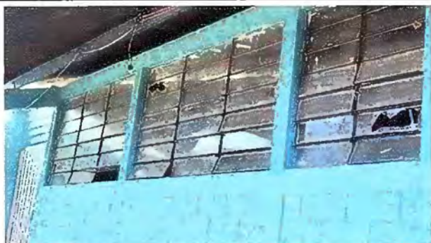
Foto 5: Módulo 2: Sustitución de vidrios
