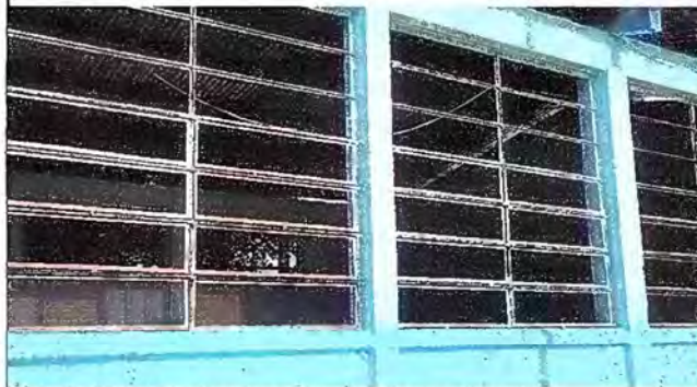
Foto 8: Módulo 3: Construcción de balcones de metal
