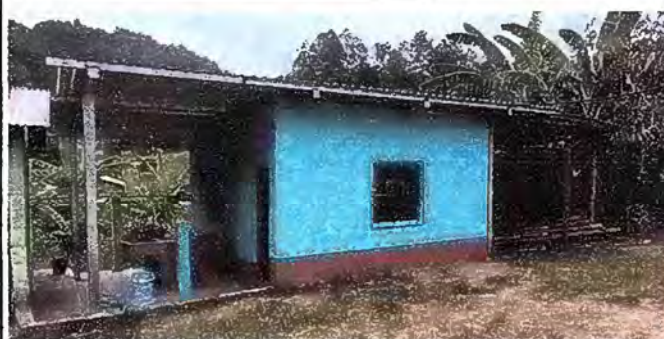
Foto 10: MODULO 2: PINTURA EN MUROS EXTERIORES E INTERIORES
