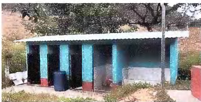
Foto 11: MODULO 3: SUSTITUCION DE LÁMINA
