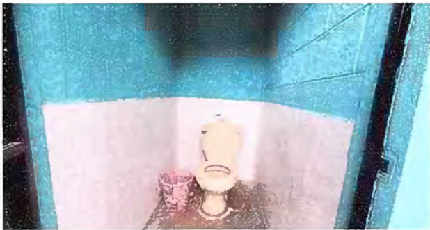
Foto 13: MODULO 3: SUTITUCION DE INODOROS
