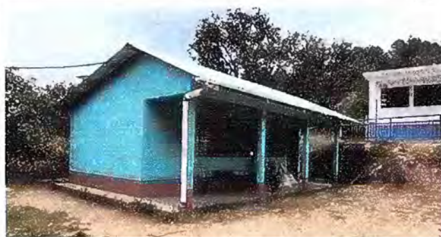
Foto 4: MODULO 1: PINTURA EN MUROS EXTERIORES E INTERIORES
