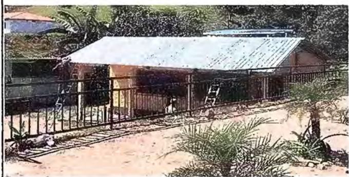
Foto1: MODULO 1: SUSTITUCIÓN DE LÁMINA
