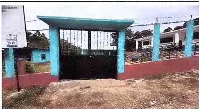
Foto 15: MANTENIMIENTO A PORTONES DE METAL
