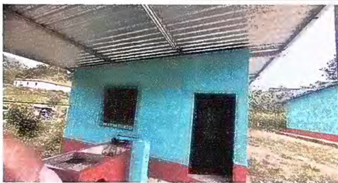
Foto 6: MODULO 2: SUSTITUCION DE LÁMINA
