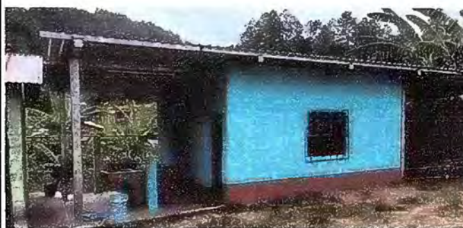
Foto 10: MODULO 2: PINTURA EN MUROS EXTERIORES E INTERIORES
