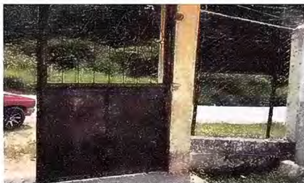
Foto 15: MANTENIMIENTO A PORTONES DE METAL
