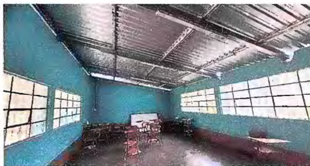
Foto 4: MODULO 1: PINTURA EN MUROS EXTERIORES E INTERIORES
