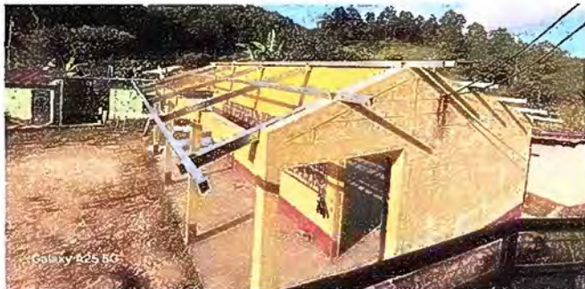
Foto1: MODULO 1: SUSTITUCIÓN DE LÁMINA
