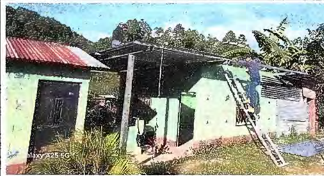
Foto 6: MODULO 2: SUSTITUCION DE LÁMINA
