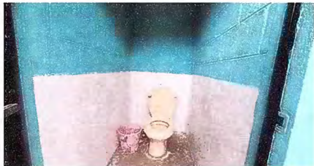
Foto 13: MODULO 3:SUTITUCION DE INODOROS
