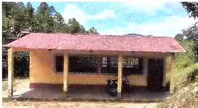
Foto1: MODULO 1: SUSTITUCIÓN DE LÁMINA
