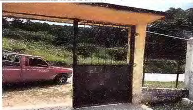
Foto 15: MANTENIMIENTO A PORTONES DE METAL
