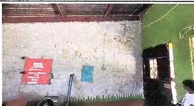
Foto 4: MODULO 1: PINTURA EN MUROS EXTERIORES E INTERIORES
