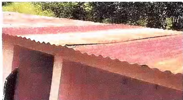
Foto 11: MODULO 3: SUSTITUCION DE LÁMINA
