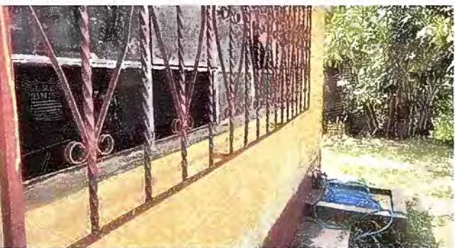
Foto 5: MODULO 1: SUSTITUCIÓN DE VIDRIOS
