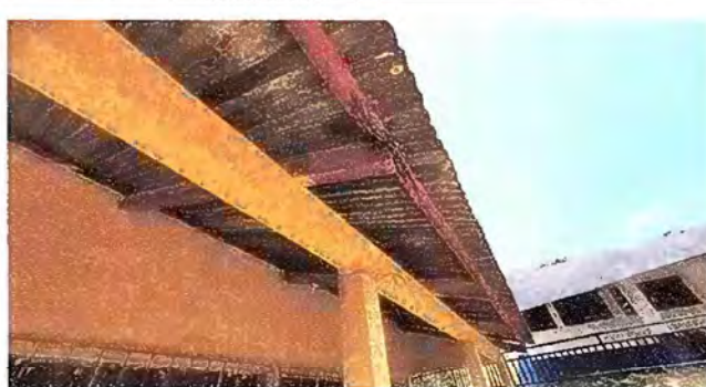
Foto 2: MODULO 1: SUSTITUCION DE SOPORTE DE MADERA POR METAL
