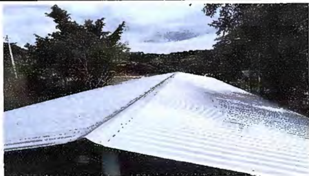
Foto1: MODULO 1: SUSTITUCIÓN DE LAMINA
