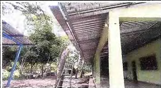
Foto1: MODULO 1: SUSTITUCIÓN DE LAMINA
