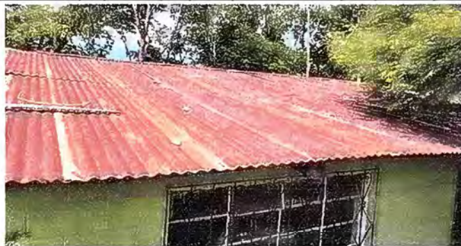
Foto1: MODULO 1: SUSTITUCIÓN DE LAMINA
