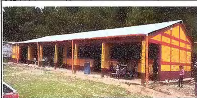
Foto 5: Pintura exterior en modulo 1, cocina y galera
