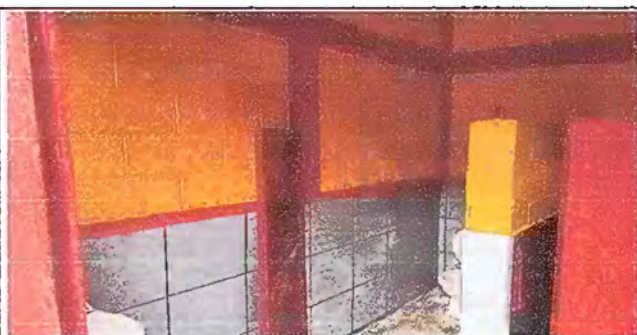
INSTALACION DE AZULEJO EN BAÑOS
