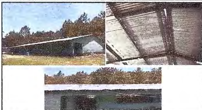
Foto1: Modulo 1: Mantenimiento de estructura de metal del techo y sustitucion de lamina en mal estado.
