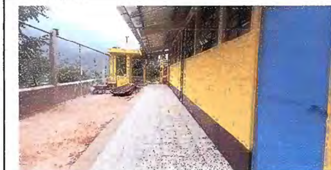
Foto 5: MODULO 1: REPARACION DE PLANCHA DE CONCRETO
