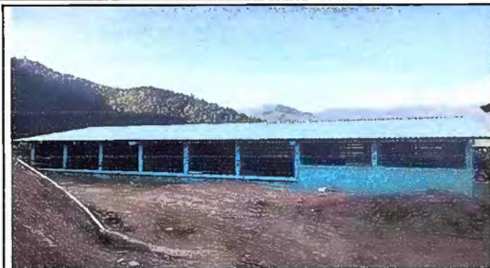
Foto1: MODULO 1: SUSTITUCIÓN DE LÁMINA
