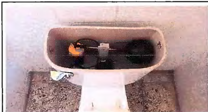
Foto 3: MODULO 1: SUSTITUCION DE ACCSESORIOS DE SANITARIOS
