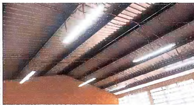
Foto 2: MODULO 1: SUSTITUCIÓN DE LAMPARAS
