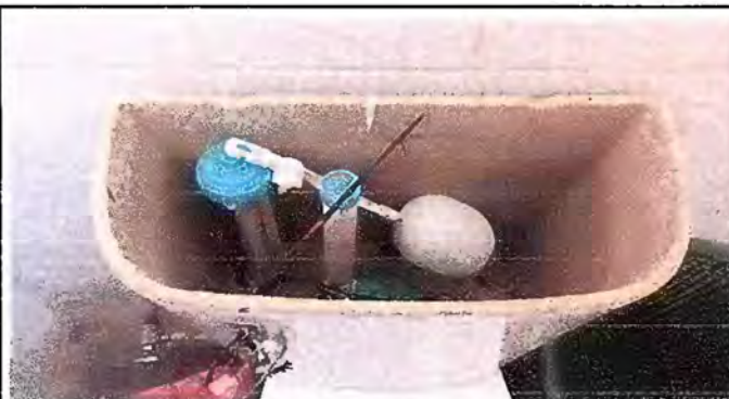
Foto 3: MODULO 1: SUSTITUCION DE ACCSESORIOS DE SANITARIOS
