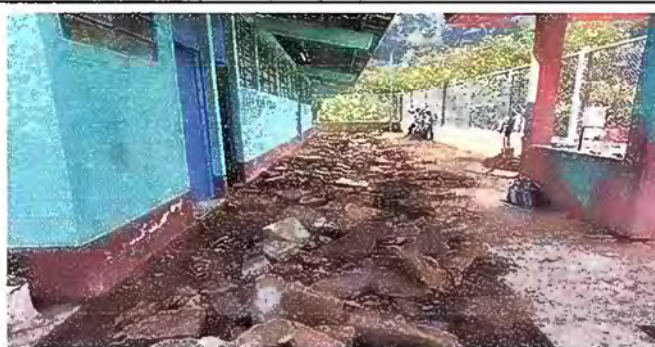
Foto 5: MODULO 1: REPARACION DE PLANCHA DE CONCRETO
