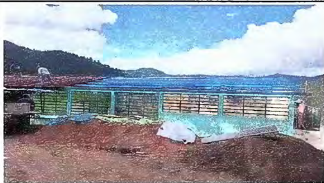
Foto 1: MODULO 1: SUSTITUCIÓN DE LÁMINA
