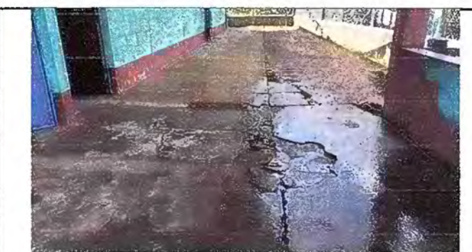
Foto 5: MODULO 1: REPARACION DE PLANCHA DE CONCRETO
