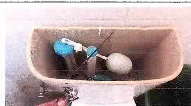
Foto 3: MODULO 1: SUSTITUCION DE ACCSESORIOS DE SANITARIOS
