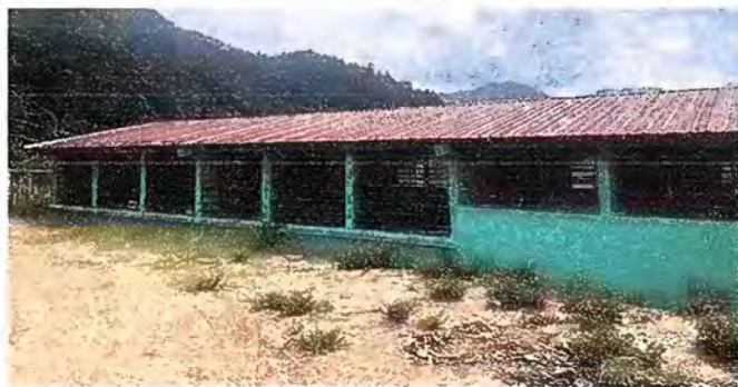
Foto1: MODULO 1: SUSTITUCIÓN DE LÁMINA
