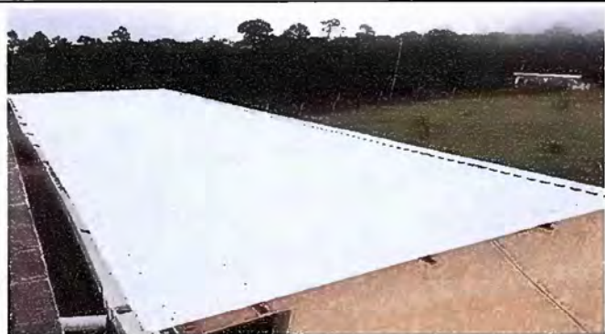
Foto1: MODULO 1: SUSTITUCION DE LÁMINA
