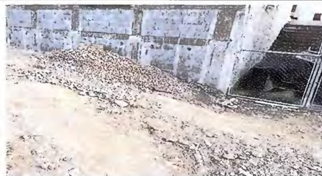
Foto 4: REPARACION DE MURO DE CONTENCIÓN
