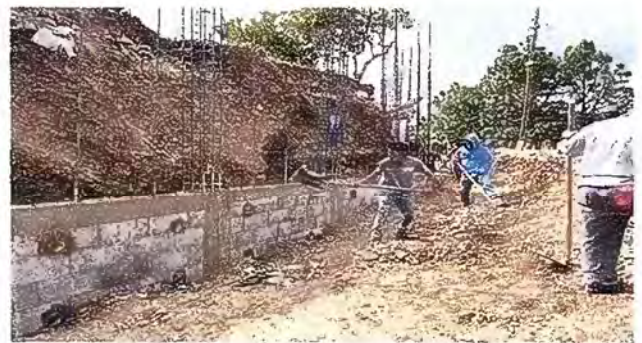
Foto 4: REPARACION DE MURO DE CONTENCIÓN
