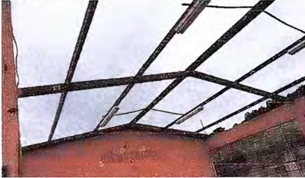
Foto 1: MODULO 1: SUSTITUCION DE LÁMINA
