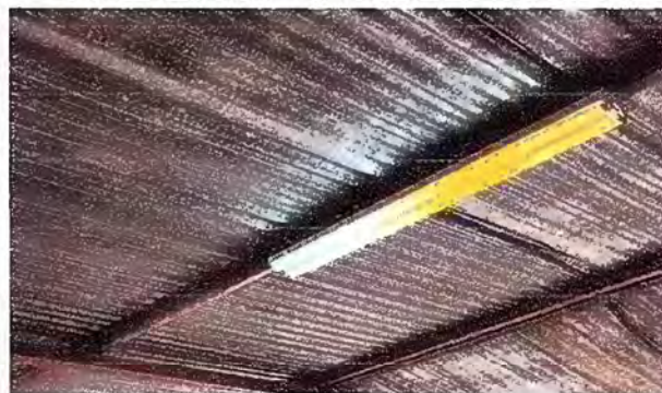
Foto 2: MODULO 1: SUSTICIÓN DE LAMPARAS
