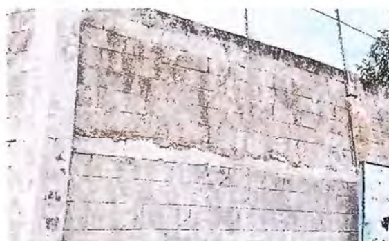
Foto 4: REPARACION DE MURO DE CONTENCIÓN
