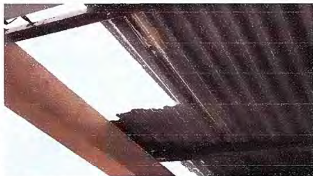
Foto 1: MODULO 1: SUSTITUCION DE LÁMINA
