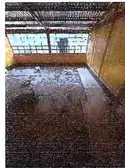
Foto 2: Modulo 1: Sustitucion de torta de cemento en mal estado de las dos aulas por piso ceramico.
