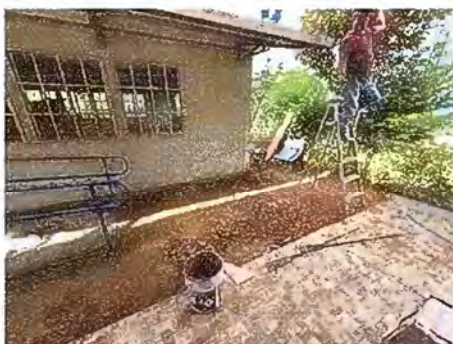
Foto 3: Modulo 2: Fundición de Torta de Cemento en area del modulo pre frabricado.
