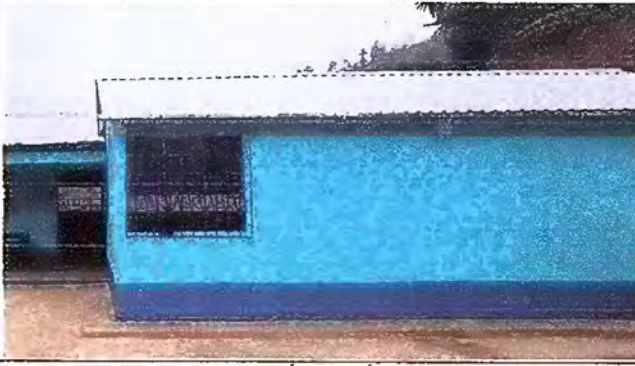
Foto 6: MODULO 2: SUSTITUCIÓN DE LÁMINA
