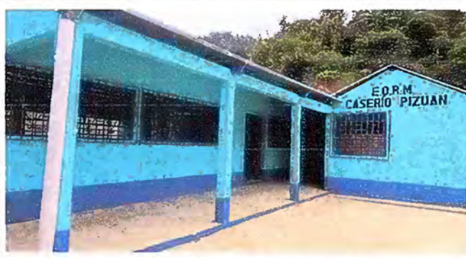
Foto 8: MODULO 2: PINTURA EN MUROS EXTERIORES E INTERIORES
