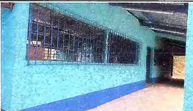
Foto 4: MODULO 1: SUSTITUCIÓN DE BALCONES
