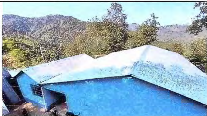
Foto1: MODULO 1: SUSTITUCIÓN DE LÁMINA
