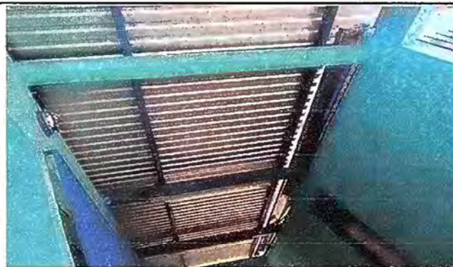
Foto 2: MODULO 1: SUSTITUCION DE CANAL
