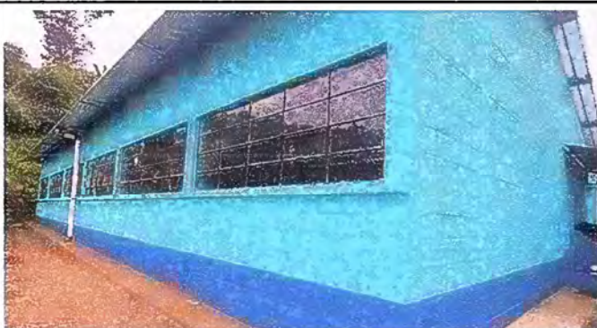
Foto 3: MODULO 1 : PINTURA EN MUROS EXTERIORES E INTERIORES
