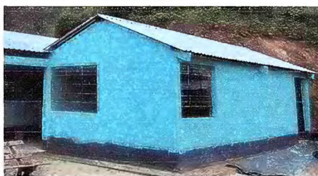
Foto 8: MODULO 2: PINTURA EN MUROS EXTERIORES E INTERIORES
