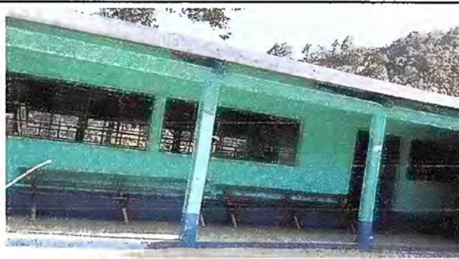
Foto 4: MODULO 1: SUSTITUCIÓN DE BALCONES
