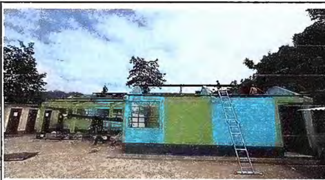
Foto 2: MODULO 1: SUSTITUCION DE CANAL
