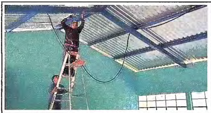
Foto5: MODULO 1: SUSTITUCIÓN DE LÁMPARAS
