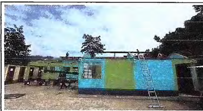
Foto 6: MODULO 2: SUSTITUCIÓN DE LÁMINA
